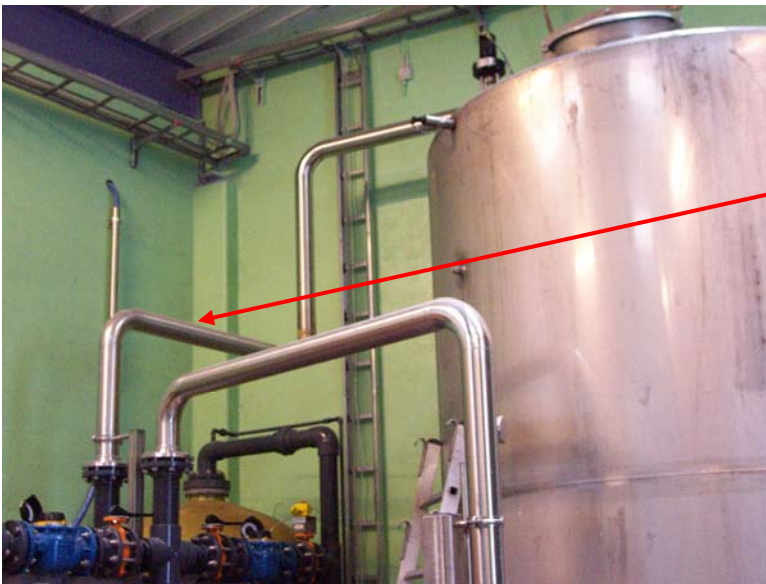
Figur 1. Eksempel, hvor der anvendes flere bøjninger end nødvendigt, hvilket fører til øgede omkostninger
